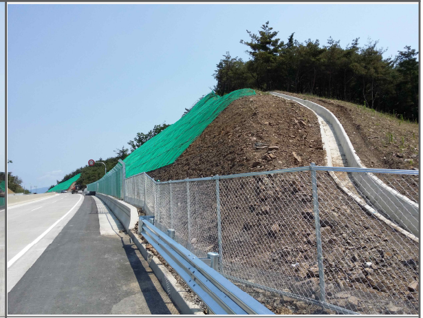
② 절토사면 시공 현황(중점 횡단)
