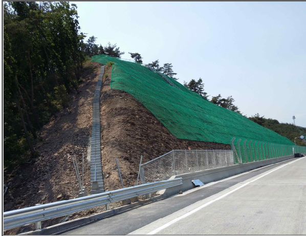
① 절토사면 시공 현황(시점 횡단)
